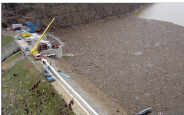
Obr. 1: Hráz vodního díla Znojmo s velkým množstvím dřeva naplaveného při povodni na jaře 2006, foto Pavel Kožený (VÚV TGM)
