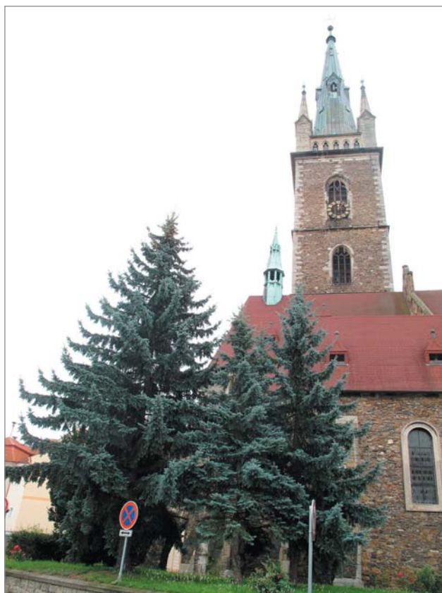
Obr. 7 Nevhodný sortiment skupiny stromů zakrývá jednu z nejvýznamnějších staveb historického jádra města i průhled a vzájemnou propojenost dvou větších veřejných prostranství (Čáslav)
