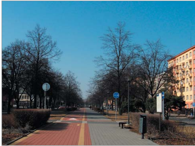
Obr. 3 Obytný soubor v Ostravě Porubě realizovaný v 50. letech ve stylu socialistického realismu je organizován okolo velkorysý osy podtržené čtyřřadým stromořadím (foto autorka)
