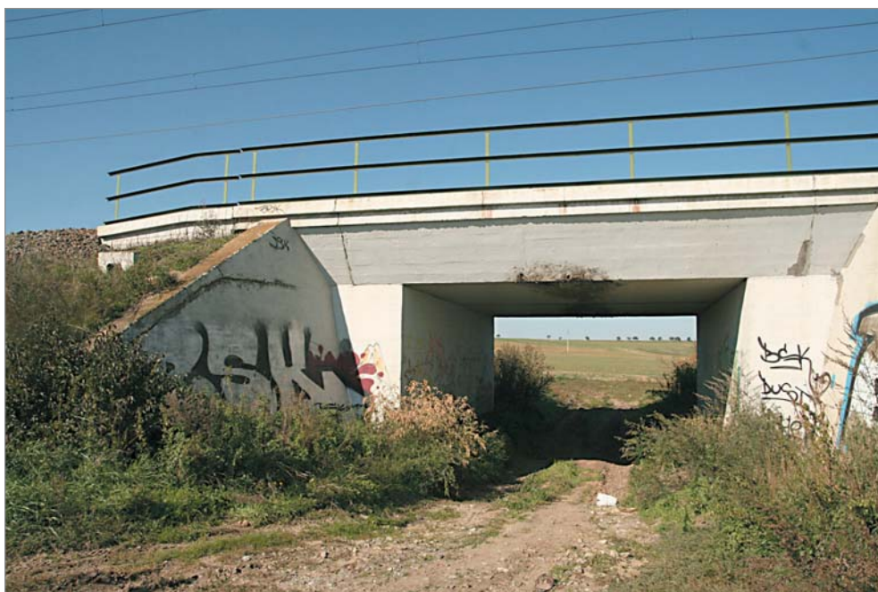
Obr. 8 Jeden z kvalitně technicky řešených průchodů na železničním koridoru mezi Starým Městem a Huštěnovicemi je multifunkčním objektem sloužícím také pro zemědělské účely
