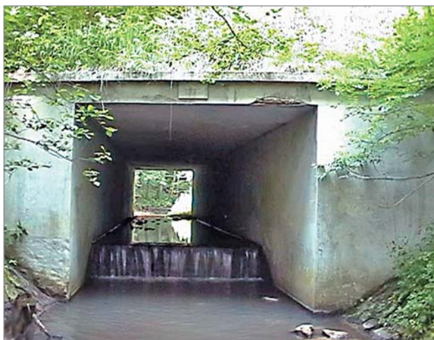
Obr. 9 Původně stavebně špatně řešený objekt u obce Stupava před a po rekonstrukci silnice I/50, která jeho rozměry ještě více zmenšila
