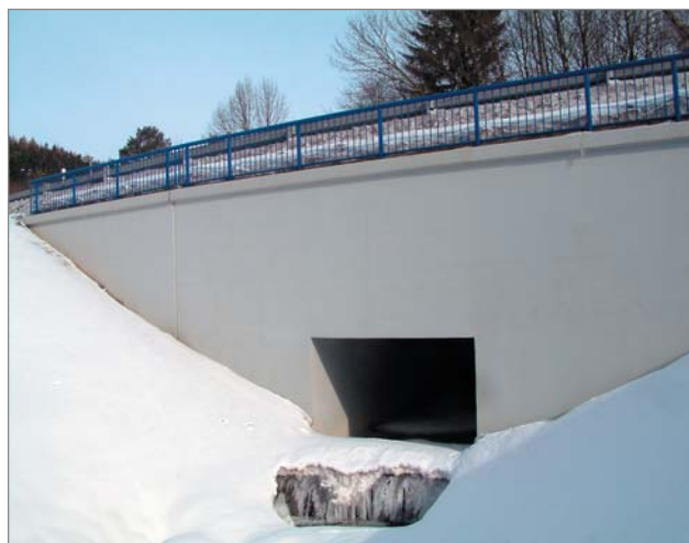
Obr. 9 Původně stavebně špatně řešený objekt u obce Stupava před a po rekonstrukci silnice I/50, která jeho rozměry ještě více zmenšila
