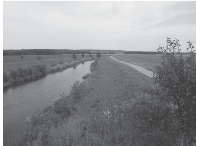
Obr. 9 Kanalizovaný tok Doubravy od Habrkovic k ústí do Labe (foto M. Weber)
