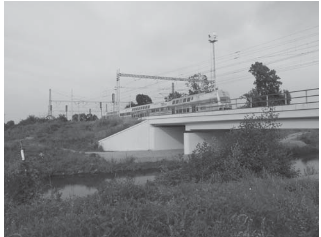
Obr. 3 Území je významnou dopravní křižovatkou – železniční koridor u Záboří nad Labem (foto M. Weber)
